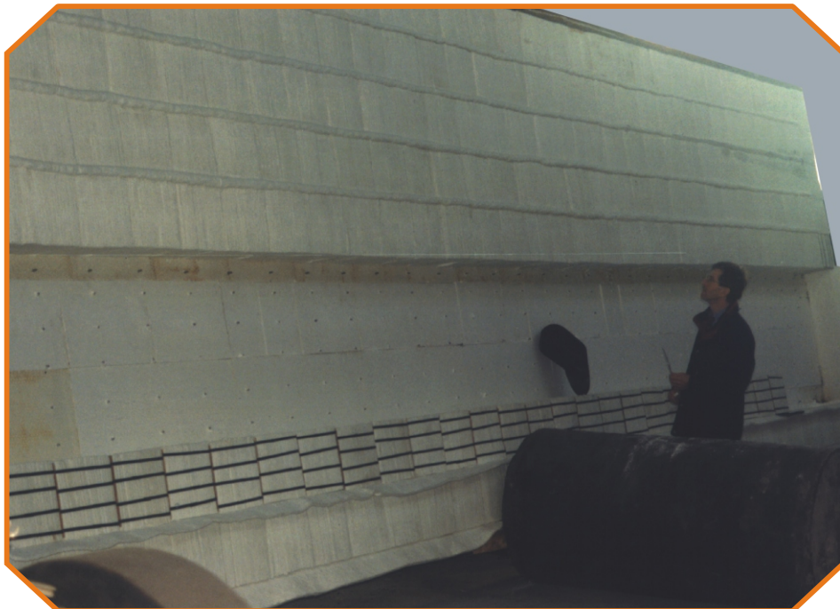
Zustellung mit hochverdichteten ( 220 \text{ kg/m}^3 ) WEITHERM CFS 1430/220 - Modulen
