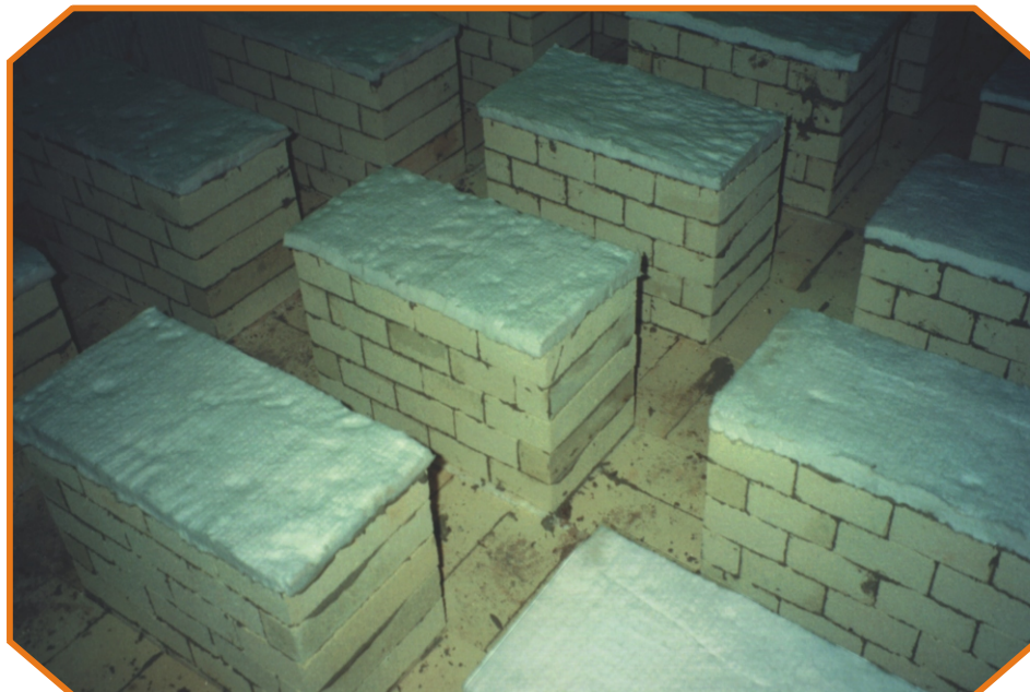
Auflagebänke für Bleibadwanne mit WEITHERM FL - Steinen und WEITHERM CTM - Matten
