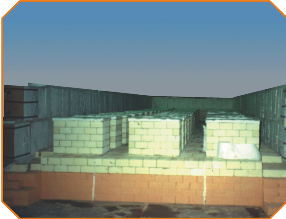
Bleibadunterbau 750 °C mit WEITHERM FL - Steinen und WEITHERM CFS - Modulen
