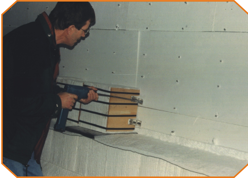
Montage der WEITHERM CFS - Module auf Hinterdämmung mit WEITHERM CTV - Platten.
