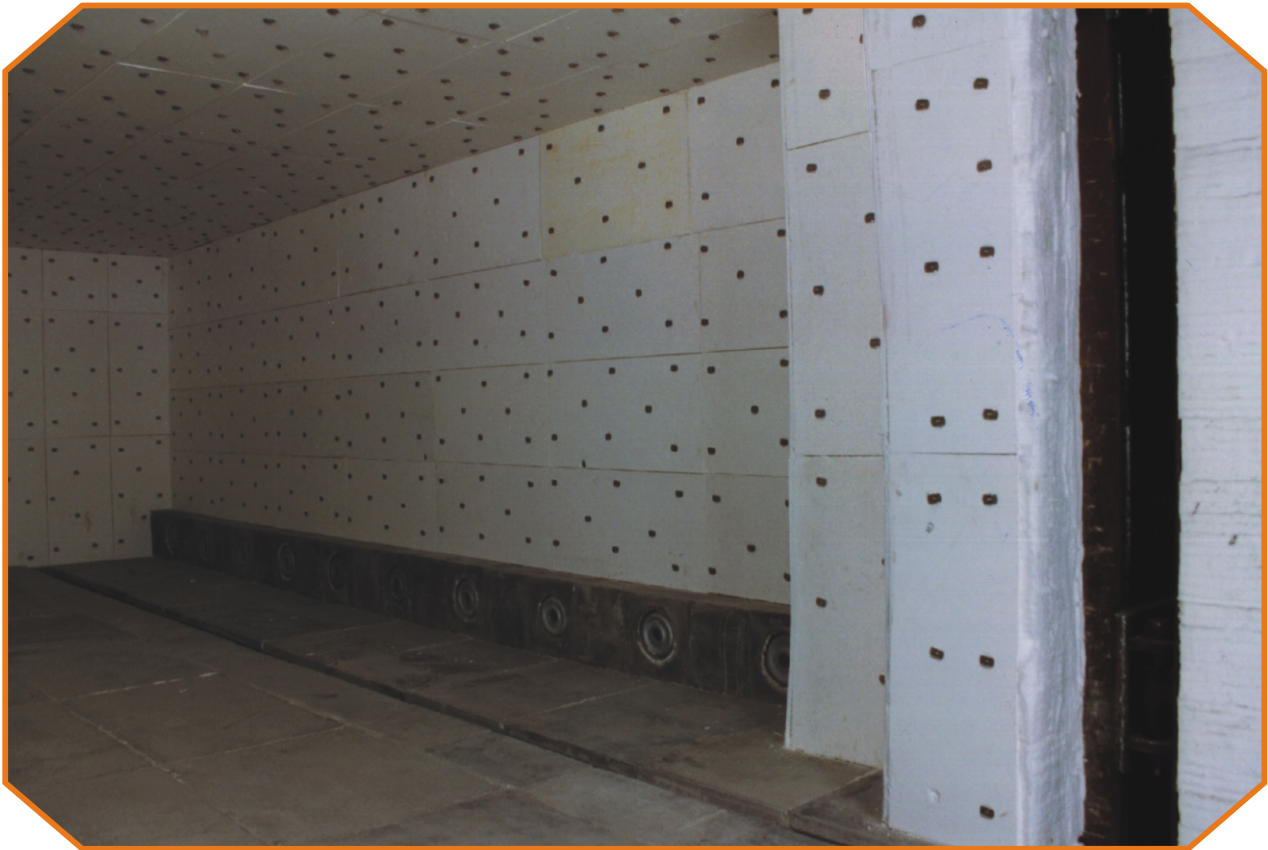
Herdwagenfront und Brennerbank mit WEITHERM CAST 1350/2.1 Hinterdämmung mit WEITHERM CS1000
