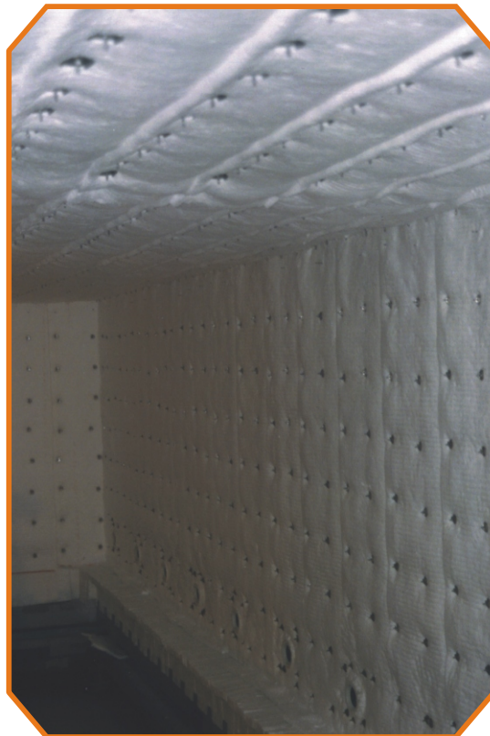
Seitenwände und Decke mit WEITHERM CTM - Matten Hinterdämmung mit WEITHERM CMF 750 - Mineralfaserplatten.
