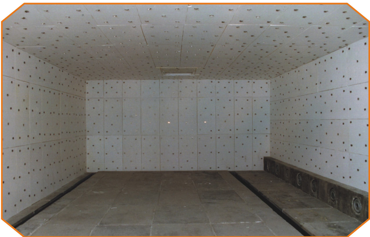
Herdwagenzustellung mit Hinterdämmung aus WEITHERM CS 1000 - Calciumsilikatplatten
